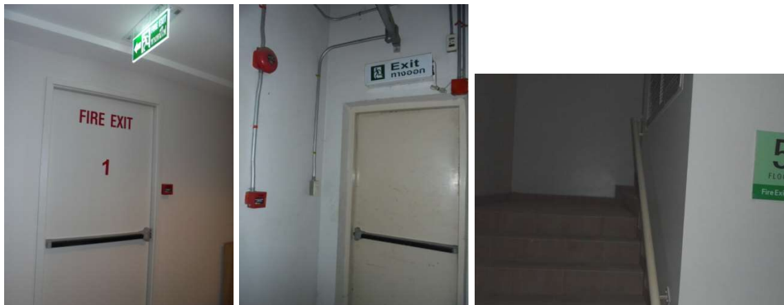
ภาพที่ 4-22 ประตูหนีไฟ บันไดหนีไฟและป้ายบอกทางหนีไฟ
