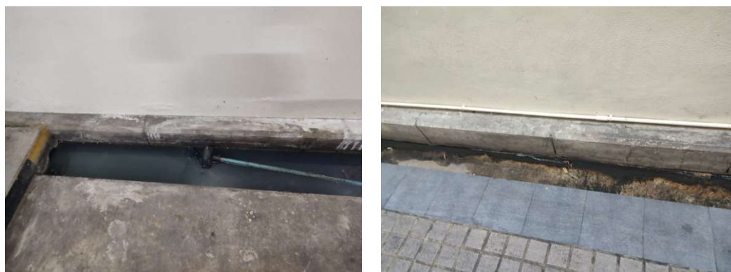
ภาพที่ 4-23 ลอกท่อระบายน้ำ มีตะกั่วอุดตันขย่ะ ปัจจุบันสามารถระบายน้ำได้เป็นอย่างดี รางระบายน้ำอยู่ในสภาพดีสะอาด
