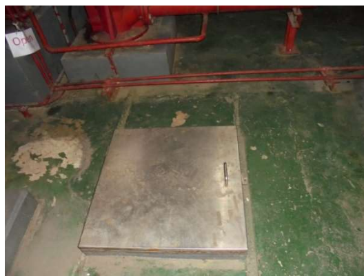
ภาพที่ 4-24 สภาพฝาลังสำรองน้ำใต้ดิน ปิดมิดชิดและมีขอบยกสูงจากพื้น
